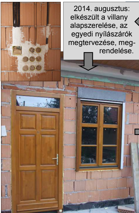
2014. szeptember: elkészült a helyiségek belső vakolása, valamint beépítésre kerültek a nyílászárók: ajtók és ablakok.
