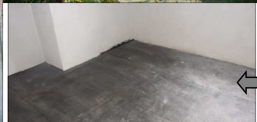
2014. november elkészültek a fűtés- és vízvezeték szerelési munkák, az aljzat szigetelés.
