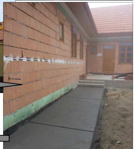
2014. október: elkészült a helyiségek aljzat-szigetelése, valamint folytatódtak a villanszerelési munkák is. Az udvarban pedig elkészültek a ház körül a járdák.
