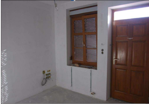
2015. áprilisig: a téli hónapokban folyamatosan haladtak a tervezett munkálatok, elkészült az összes belső szerelvényezés (fűtés, vízvezetékek kiépítése), illetve az aljzatbeton, a vakolás.
