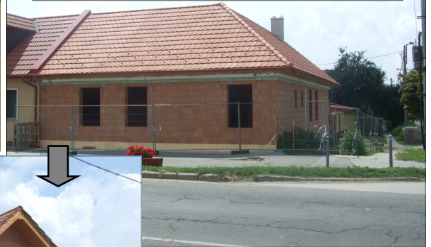
2014. július: elkészült a tető cserépfedése és a bádogos munkák.
