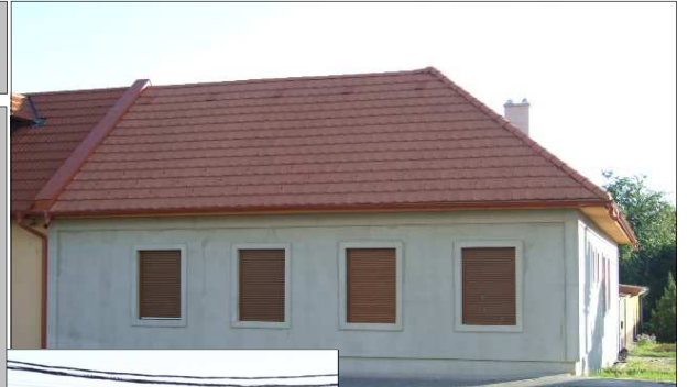
2015 június: elkészültek a meleg burkolatok megtörtént az épület külső szigetelése, vakolása, színezése.
