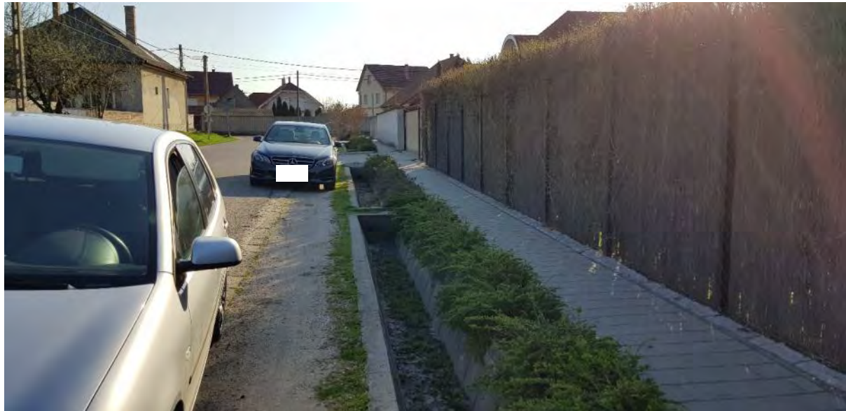
56. kép: Keskeny járdaszakasz az Iskola utcában
