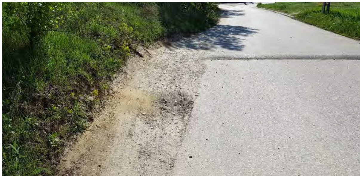
77. kép: Kistói utcában lévő sebességcsökkentő küszöb melletti kijárt útpadka
