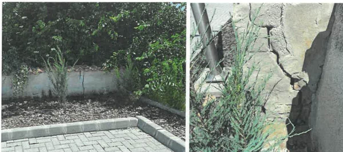
5. ábra: Bal oldali támfal lokális tönkremenetel
