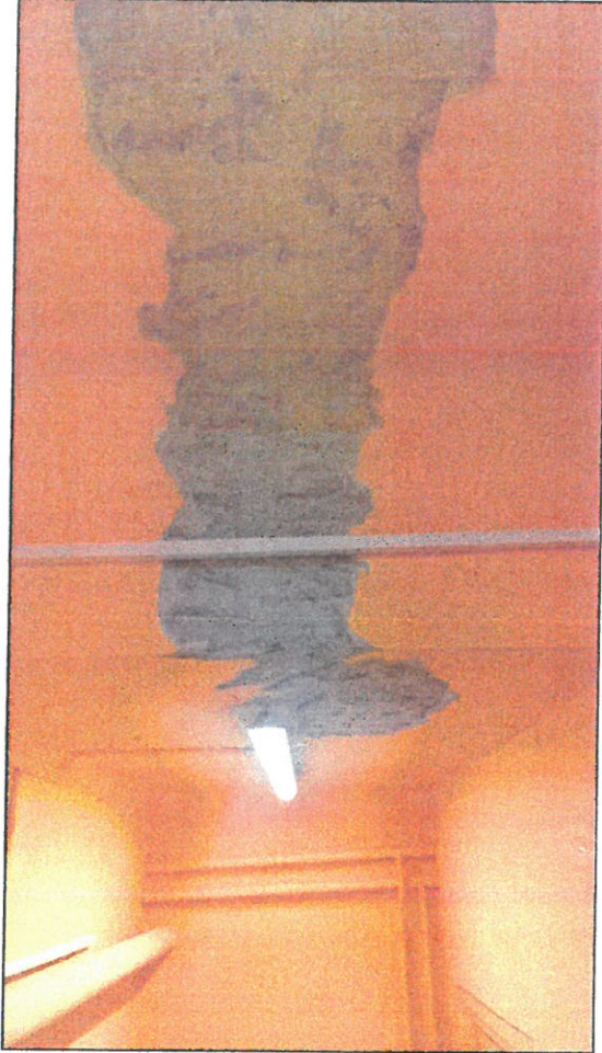
12.fotó: földszint feletti földem (folyosó): előregyártott vb. gerendák közötti betontálcás földem, monolit gerenda
