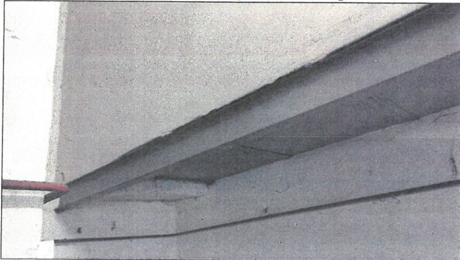
13. fotó: közbenső földémszakasz (folyosó) I 200 acélgerendás, fióktartós földem
