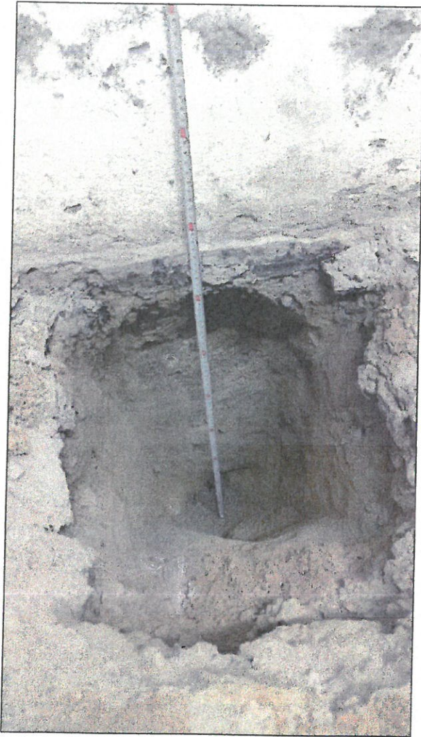
1.fotó: pincszinti alapfeltárás: falszéles beton sávalap
